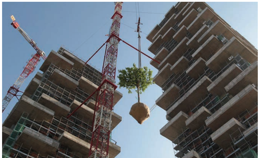
Detalj s gradilišta
