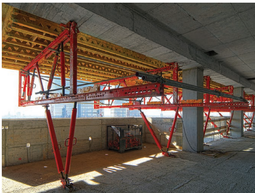
Prikaz procesa građenja konstrukcije zgrade
